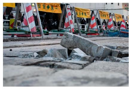
しかし、今回の補修補強工事では耐震性向上のため、線路の下にあるお茶の水橋の床版 (コンクリート層)上部に至るまで舗装を剥がし、抜本的に工事が行われます。すでに線路跡にはカッターによる切れ目が入れられており、外堀通り側にあった一部のレールは切り刻まれ、撤去されてしまいました。
