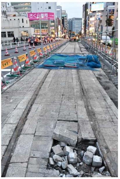
レールは路面電車(道路交通との併用区間)に特徴的な、頂部に車輪の脱線止め(フランジ)を受け止める溝がある「溝付きレール」。御影石でできた軌道敷もきれいに残されています。
