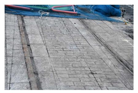
道路表面のアスファルト層は 3~5cm ほどの厚み。アスファルト舗装の平均寿命は約 10 年とされているので、これまでにも舗装工事は行われていたものの、この都電の線路跡はそのまま保存されて新たな舗装が上から施工されていたようです。
