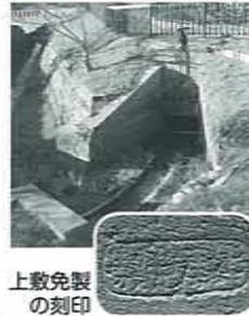
明治25年(1902)に竣工した権現堂川用水の取水水門。明治38年(1905)現在の煉瓦造りに改築された。煉瓦には「上敷免製」の刻印が見え、日本煉瓦が深谷で製造したことを示す近代化を支えた貴重な土木遺産。平成22年(2010)「権現堂川用水樋管群」として土木学会選奨土木遺産に認定される。
